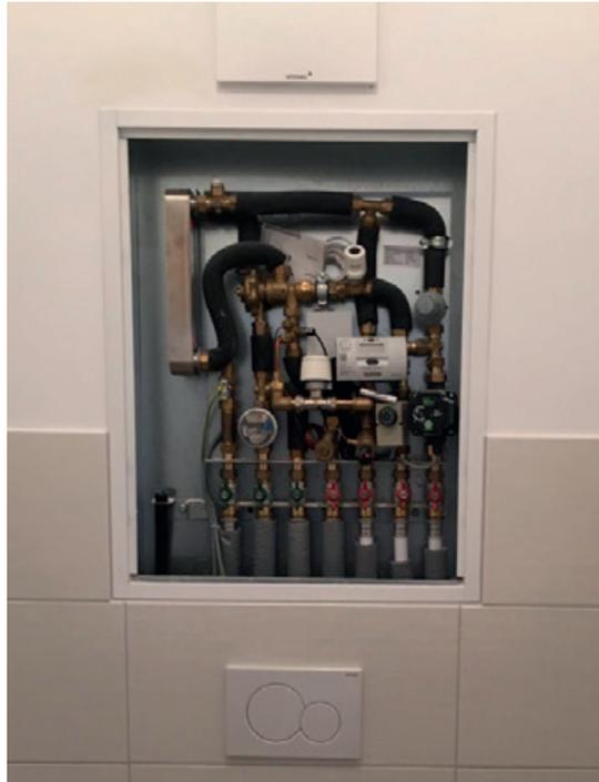
In jeder Wohnung befindet sich eine Wohnungsstation direkt über dem WC. Darin sind der Wärmetauscher und der Wasserzähler sowie Hauptwasserhahn verbaut.
