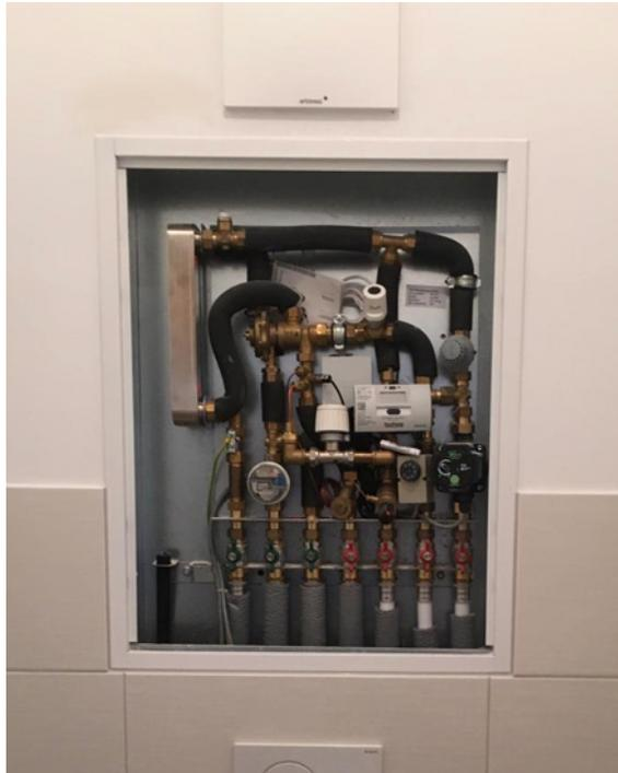
In jeder Wohnung befindet sich eine Wohnungsstation direkt über dem WC. Darin sind der Wärmetauscher und der Wasserzähler sowie Hauptwasserhahn verbaut.
